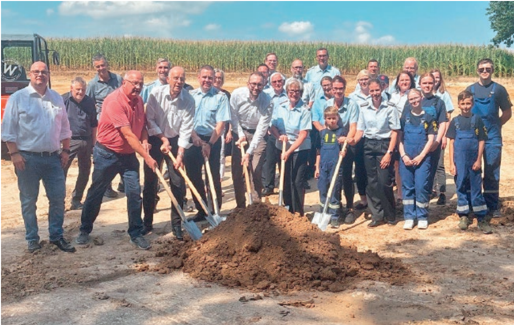
Gemeinsamer Spatenstich aller Beteiligten
