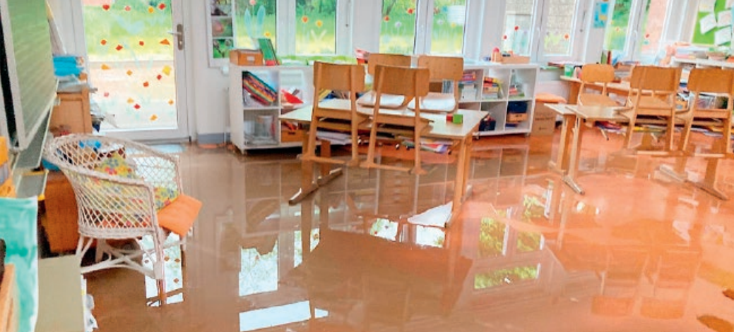
Klassenraum der Grundschule Hohenassel
