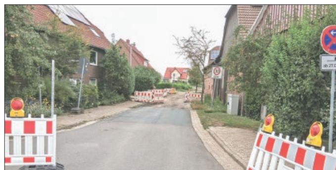
Das Hinweisschild dokumentiert den seit über vier Monate dauernden Baustopp ab Oberger Weg in Klein Lafferde.
