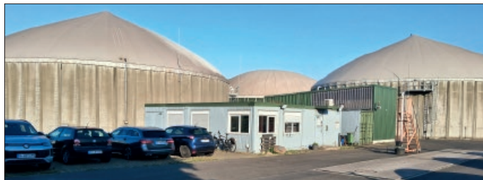
Biogas-Anlagen-Panorama im Broistedter Unternehmerpark
