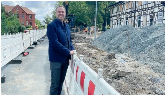
Das Fundament nimmt Form an: Bürgermeister Hoppe freut sich über Fortschritt der Umbauarbeiten.
